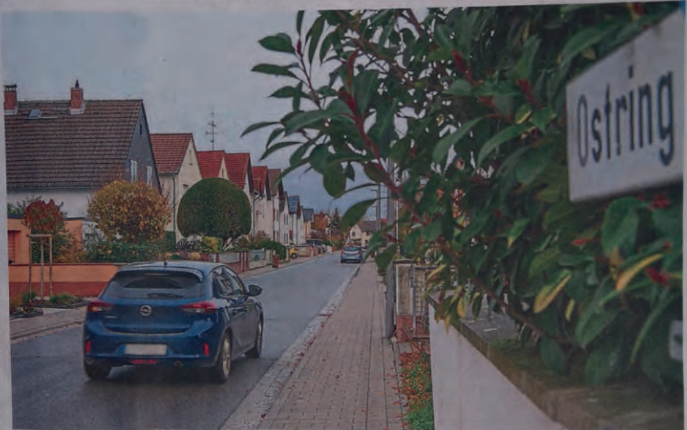
Die Interessengemeinschaft feiert einen Beschluss des Verwaltungsgerichts Darmstadt zu Beitragsbescheiden als Etappensieg im Kampf gegen Straßenbeiträge. In Leeheim, wo sich Sanierungen häufen, ist der Unmut besonders groß. Die Arbeiten am Ostring sind abgeschlossen, die an der Ortsdurchfahrt sollen 2023 beginnen.
